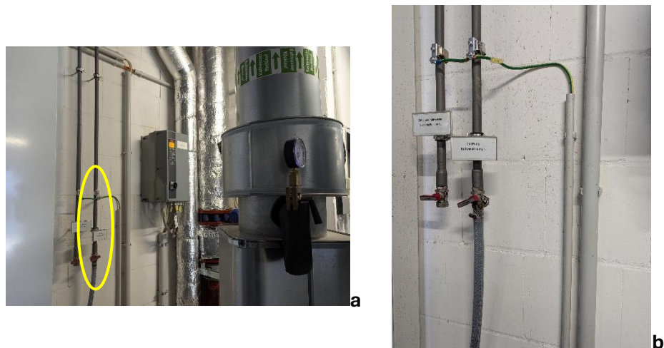
Abbildung 5: Probenahmestelle Technik-Zentrale 2, Rücklauf (26.51 TZ 2 RL)
